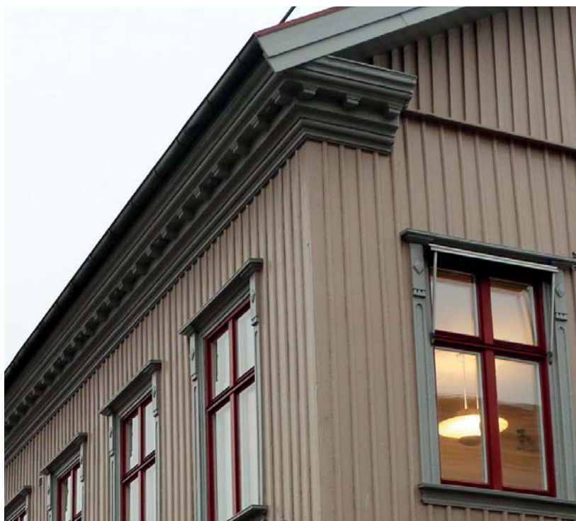
Kraftig takfot med tandlist.
