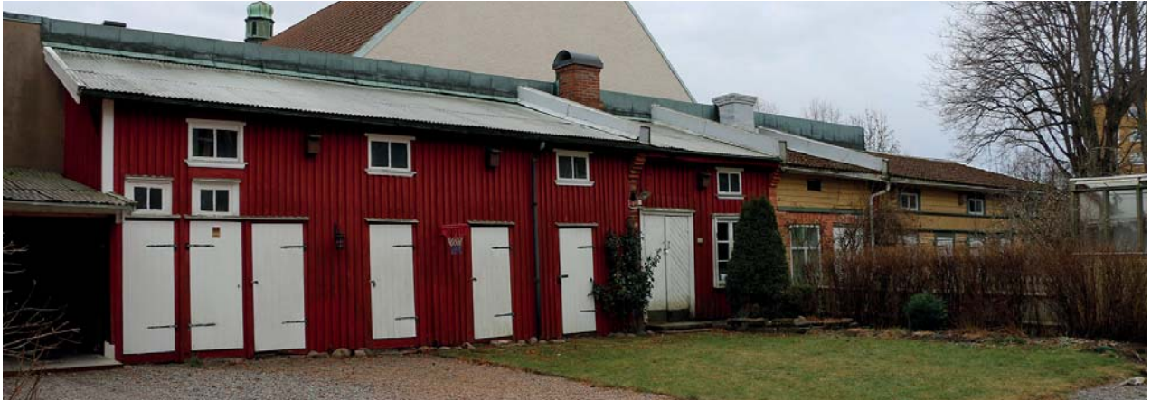
Uthuslängor vid fastighetsgräns, Ljungen 3 och 2.
