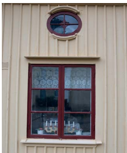
Äldre fönster, bevarade dörrar och väl utförda plåtarbeten är exempel på viktiga delar i god byggnadsvård.
