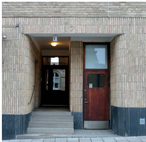
Mönstermuret tegel vid entré.
