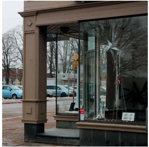
Äldre skyltfönster placerat runt hörnet.
