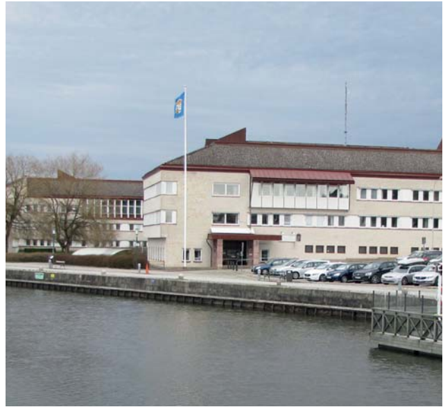
Länsstyrelsen och tingsrätten, Kv. Sälgen.
